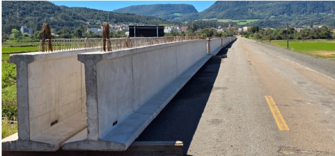
Objetivo é substituir estruturas destruídas pelas enchentes de 2024.
