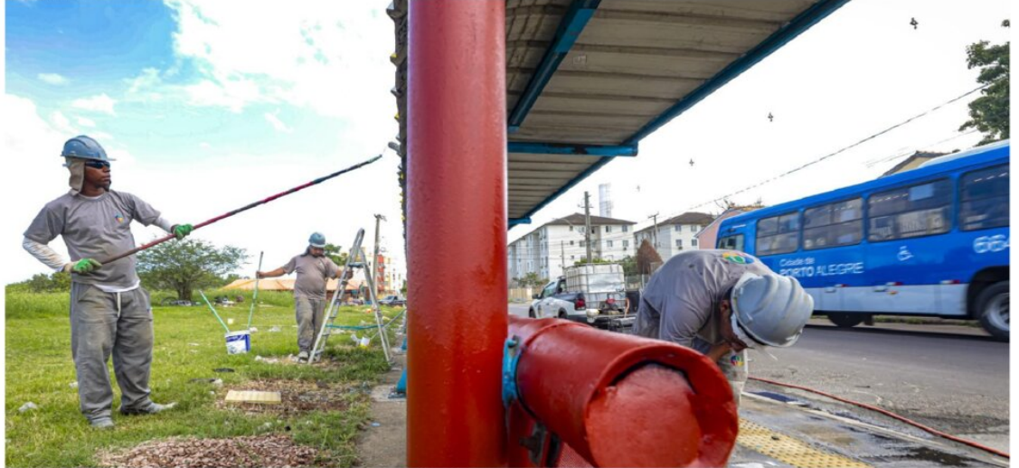
Construção da estrutura demandou cerca de dez meses.
