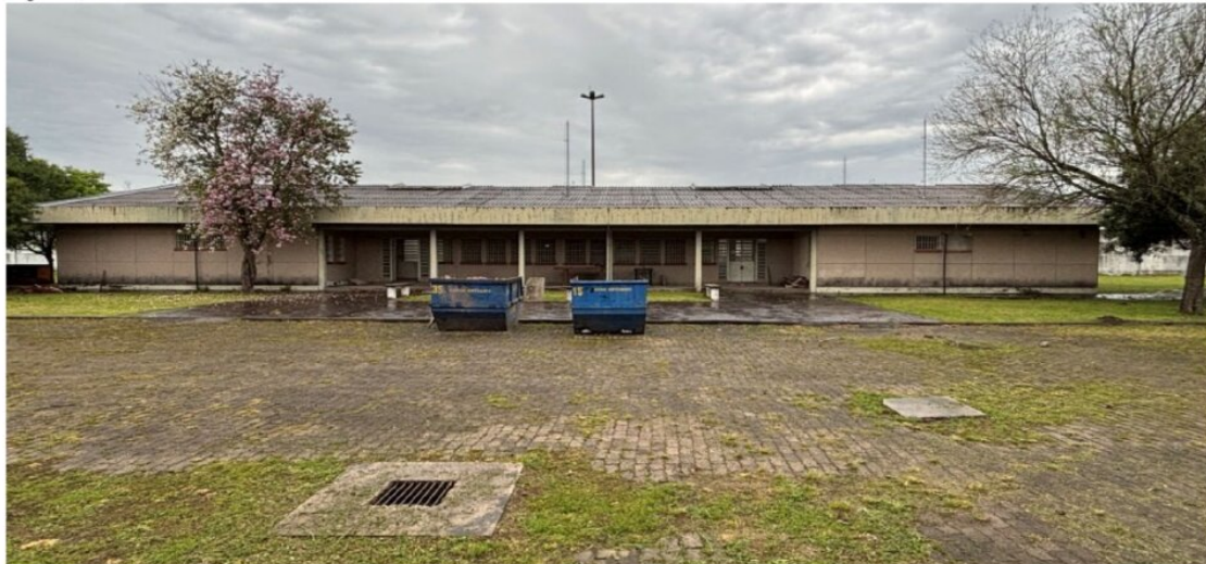
Iniciadas em setembro, obras resultarão em unidade para detentas.
