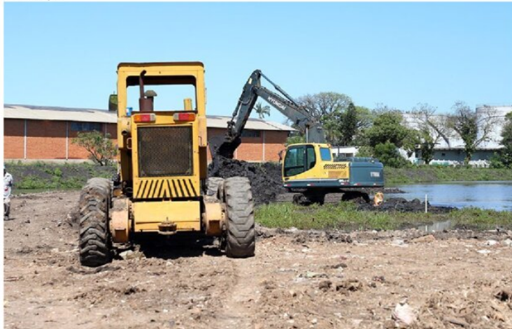
Obra já promoveu a substituição de tubos antigos de três redes de drenagem da região, trocando estruturas de concreto por tubos de PVC com diâmetros de 80 cm, 1 m e 1,2 m.
