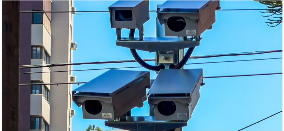
Monitoramento é realizado por cinco dispositivos de controle.
