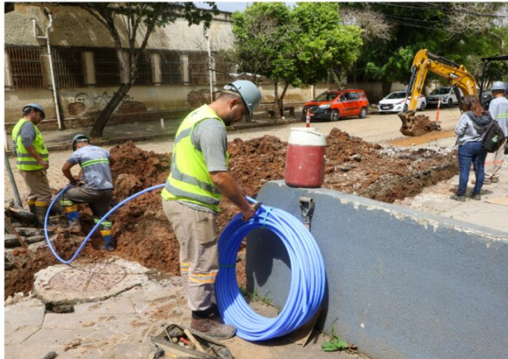
Em algumas áreas a tubulação já tem mais de 50 anos.
