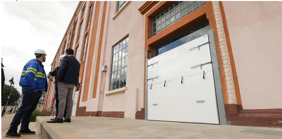
Instalação dos dispositivos deve ser concluída até o final de novembro.
