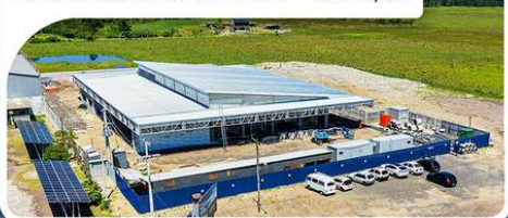
Fotos da obra da Carhouse - Osório/RS.
