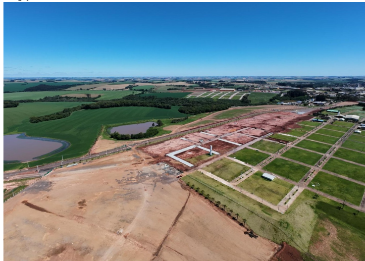
Obras estão em execução e nova configuração vai reorganizar espaços e setores dentro do parque.
