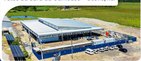
Fotos da obra da Carhouse - Osório/RS.
