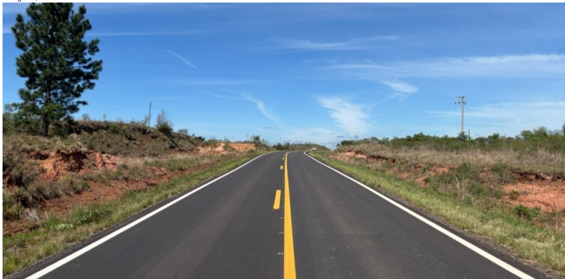
Segmento já tem cerca de 40 quilômetros de pista restaurados.
