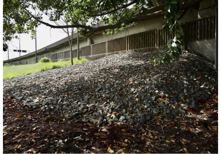
Equipes implantaram estrutura de argila e cascalho próxima à extinta comporta 9.
