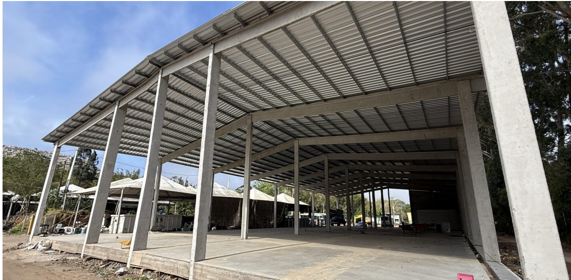
Estrutura de 1,8 mil metros-quadrados está em fase de conclusão.
