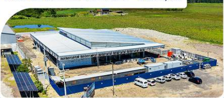
Fotos da obra da Carhouse - Osório/RS.
