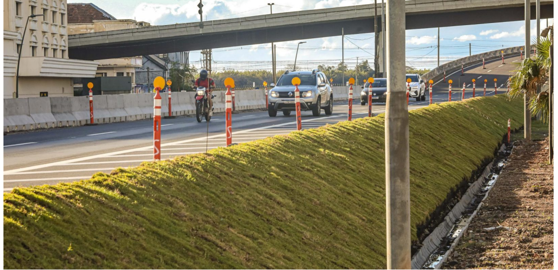
O Corredor Humanitário foi construído em caráter emergencial durante a enchente de maio de 2024.
