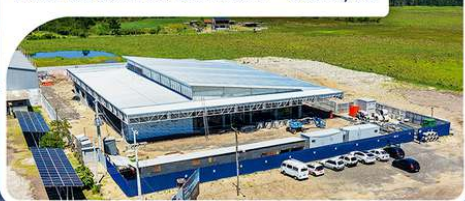
Fotos da obra da Carhouse - Osório/RS.
