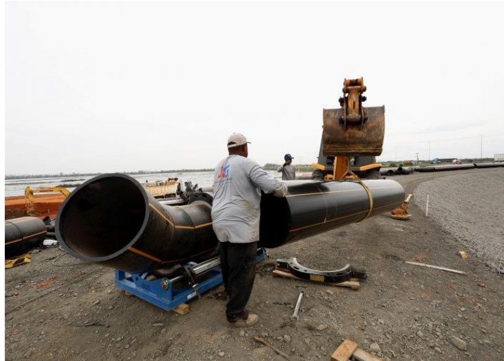
Tubulações de grande porte vão ligar o bombeamento, instalado na parte protegida, ao rio Gravataí.
