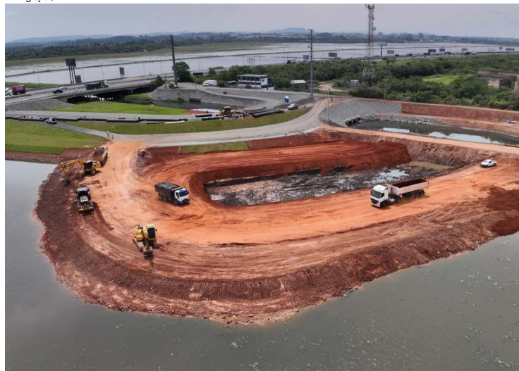
Instalação de bombas de alta capacidade será concluída nos próximos dias.
